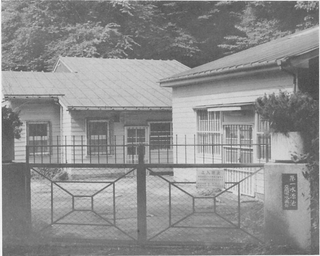
市水道第一水源池 井戸は建物の内部にある。ここから立野台の配水場へ送水する 55. 7撮
