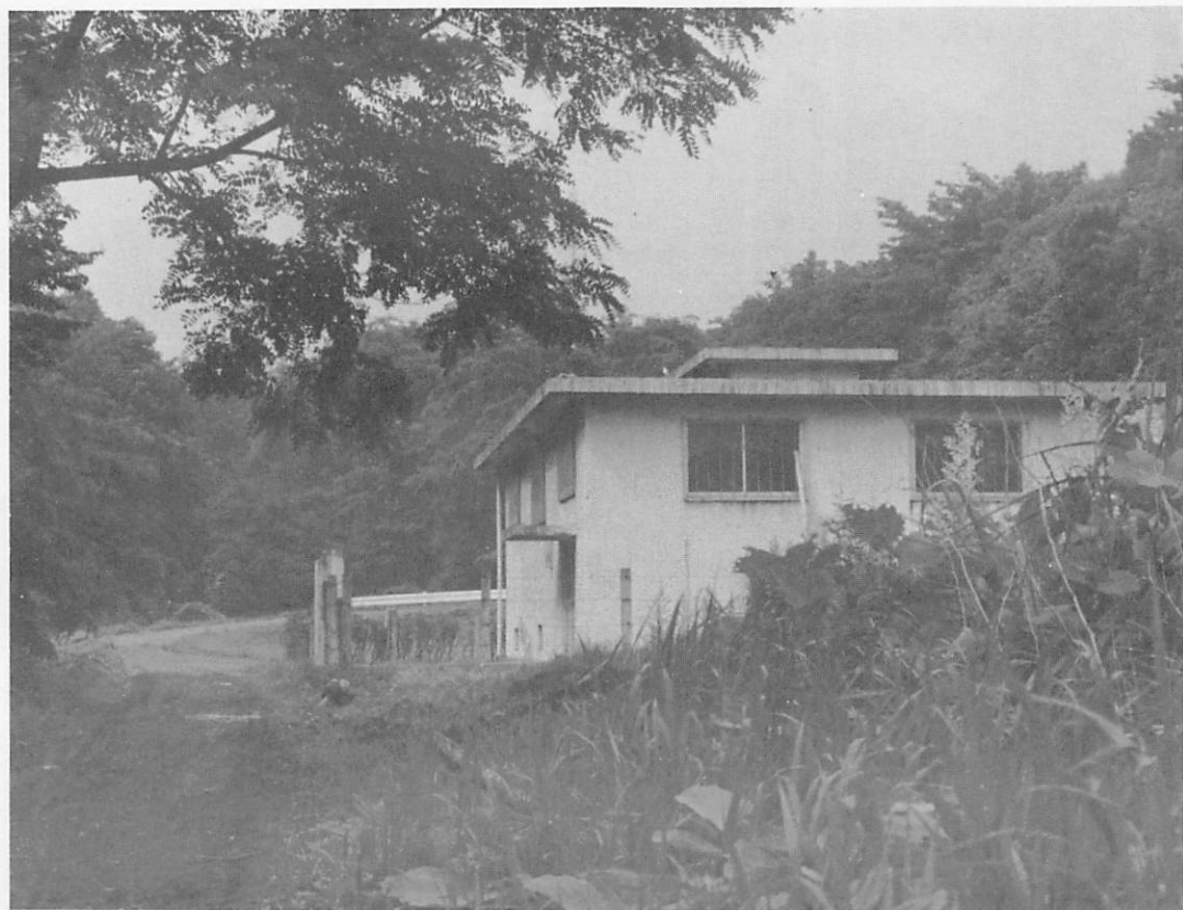
東老場 建物は市水道第二水源池。かつて水田だったところも木が生い茂っている 55. 7 撮
